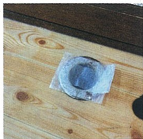
排水口に蓋をして臭いの発生を防止
