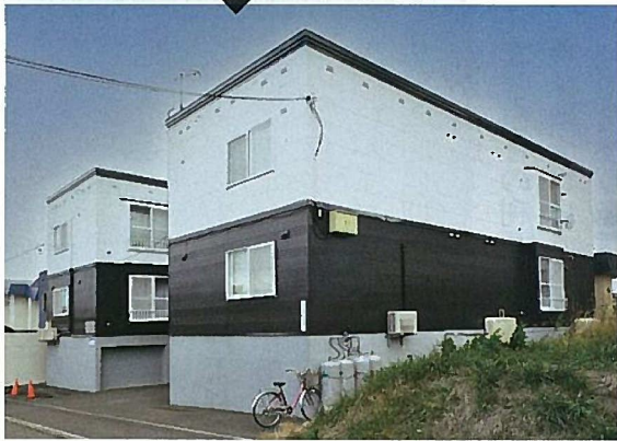
中古物件として購入後、満室稼働しているアパート
